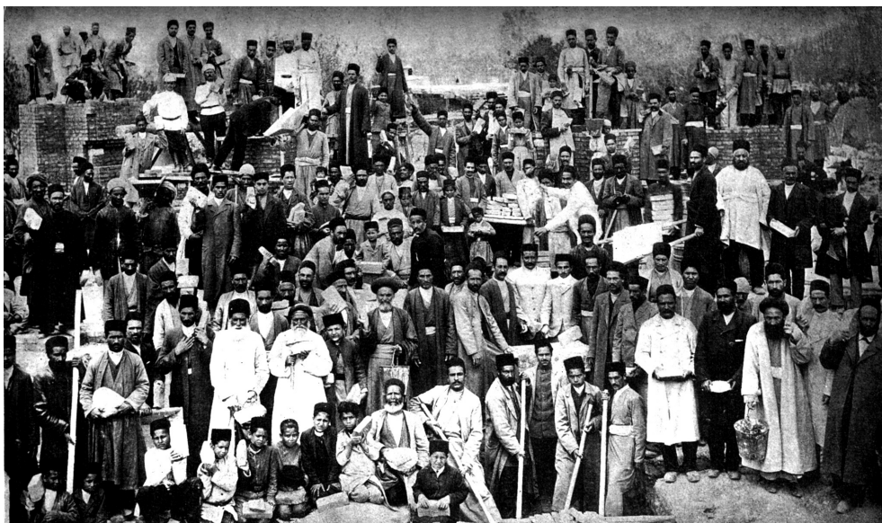
Рабочие с Афнаном (потомком Баба) на строительстве храма
